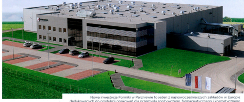
Nowa inwestycja Formiki w Parzniewie to jeden z najnowocześniejszych zakładów w Europie dedykowanych do produkcji opakowań dla przemysłu spożywczego, farmaceutycznego i kosmetycznego
